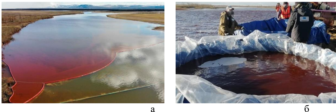
Рис.12 а,б. Боновое заграждение реки для сорбционного сбора нефтепродуктов при ликвидации последствия разлива (фото из открытых источников).
