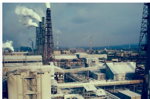
Рис.8 Завод АО «Аммофос»
