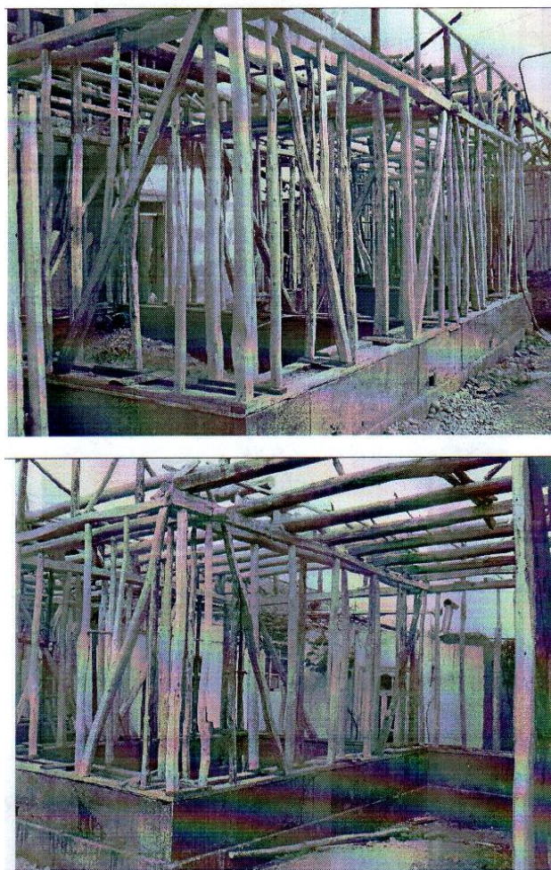
Рис.5. Исследуемые конструктивные решения синчевых каркасов строящихся зданий.
